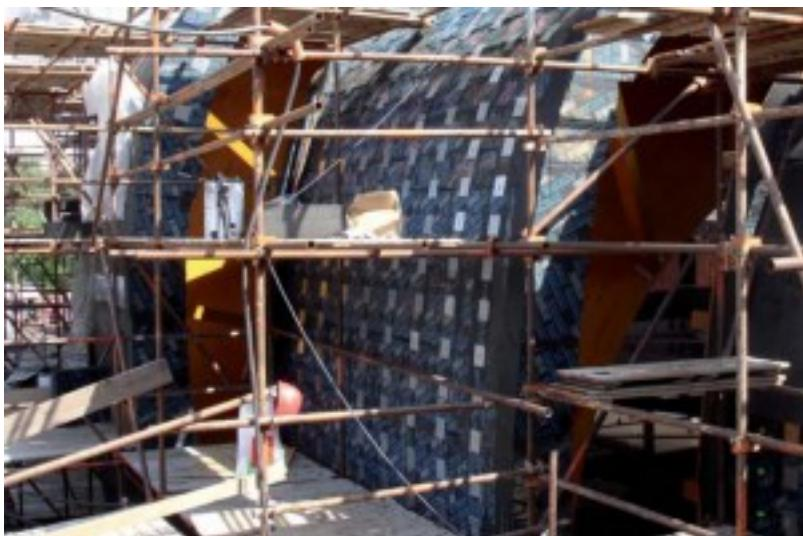
Kompaktná skladba z dosiek FOAMGLAS® READY BLOCKnáter rozostavené do budúcich lepených zastudena asfaltovým lepidlom PC 56
