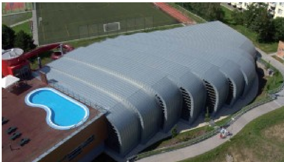
Pohľad na strechu v Brne - Kohoutoviciach
