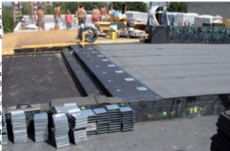
Kompaktná skladba z dvoch vrstiev dosiek FOAMGLAS® lepených do horúceho asfaltu
