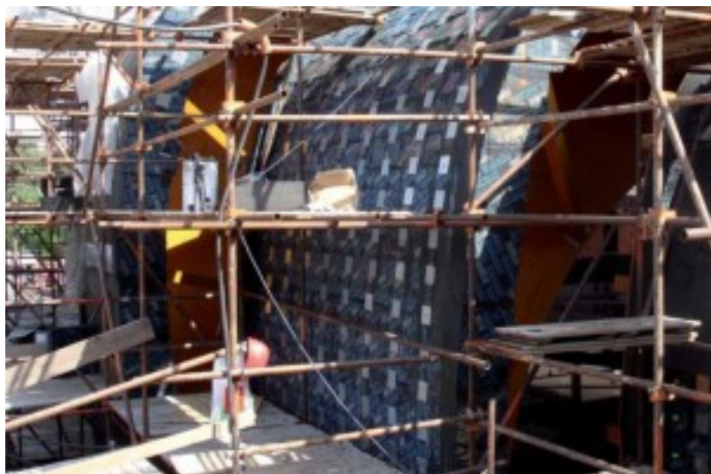
Kompaktná skladba z dosiek FOAMGLAS® READY BLOCK lepených zastudena asfaltovým lepidlom PC 56
