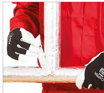
Jednoduchá izolácia T-spoja.
