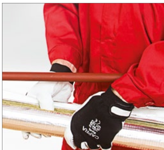
Jednoduché nasadenie puzdra na potrubie.
